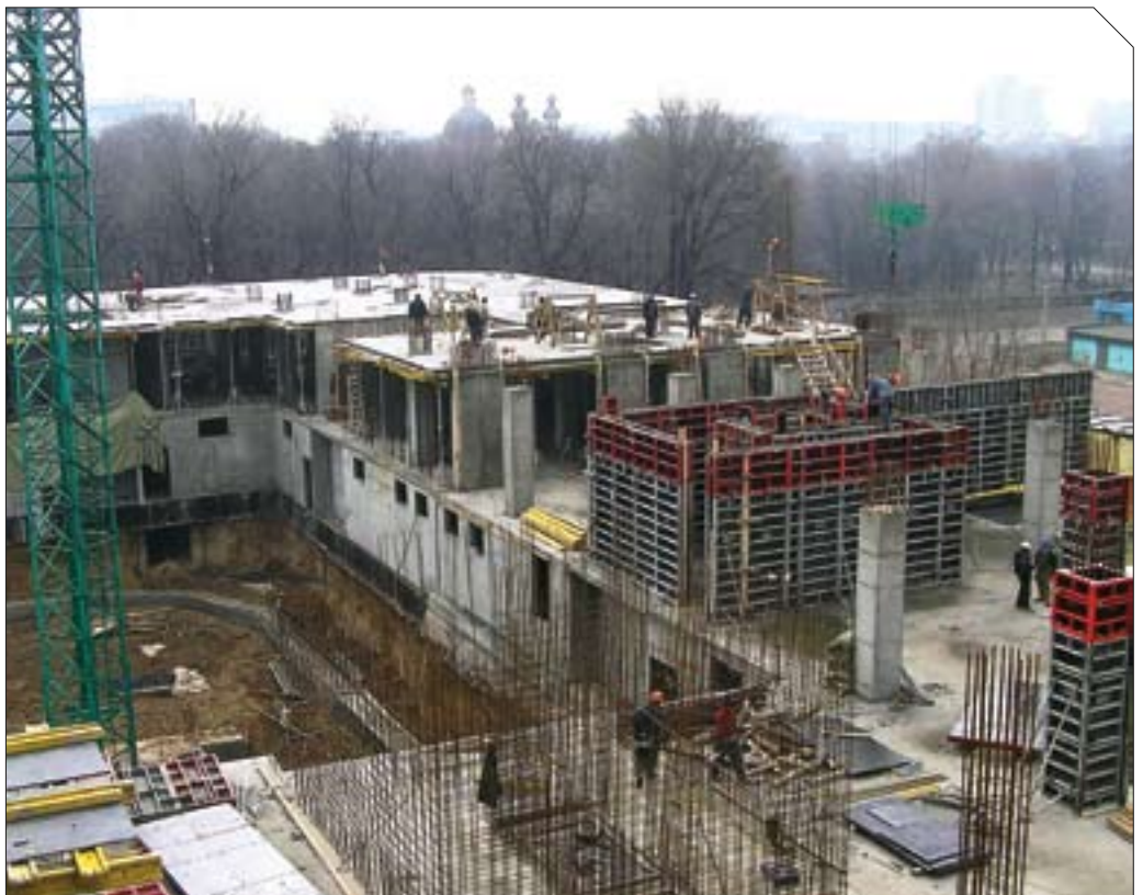
Використання добірних щитів h=1000 м. на формуванні ядра жорсткості
