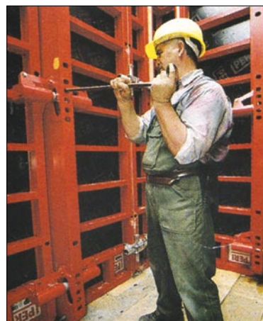
Для відокремлення від бетону необхідно підняти шахтний елемент
