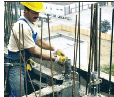
Для відокремлення від бетону необхідно підняти шахтний елемент
